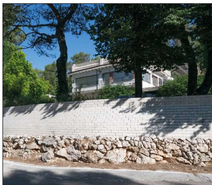
Muro PACÍFICO blanco
